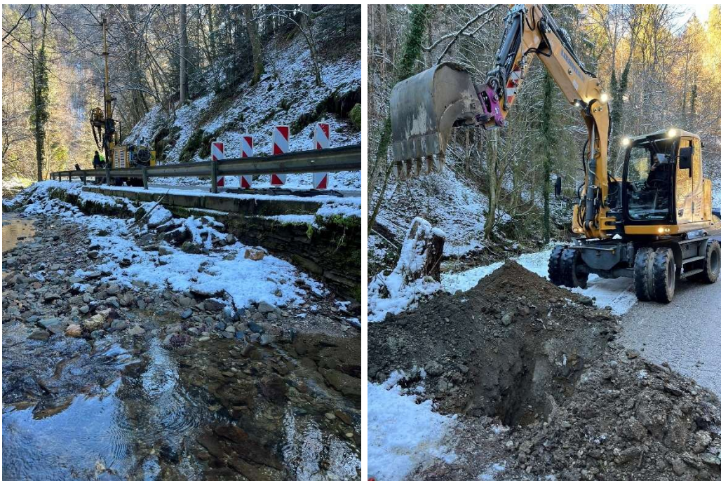
Slika 3: Izvedba geotehnične vrtine ter sondažnega izkopa
